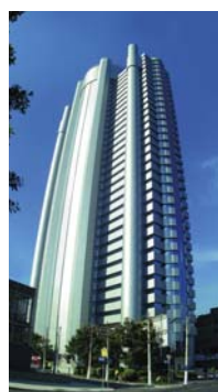
● カーテンウォール補強材の取り付け
